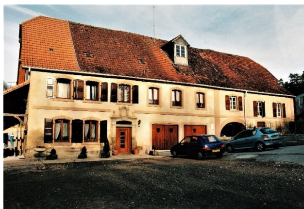
Figure 02 - Vue d'ensemble du moulin côté cour. Photo 2003
