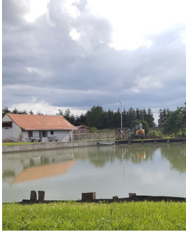
Un garde-corps à été installé
